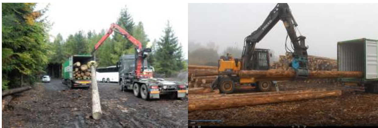
Obr. 19.40. Nakládání výřezů do 40stopých kontejnerů (hydraulickým jeřábem a rypadlem s drapákem)
