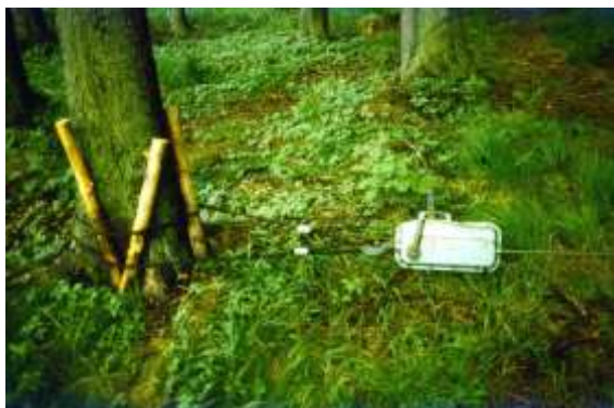
napínání nosného lana ručním navijákem
