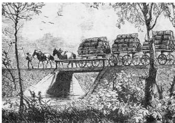
Obr. 19.1. Doprava dříví koněspřežnou železnici
