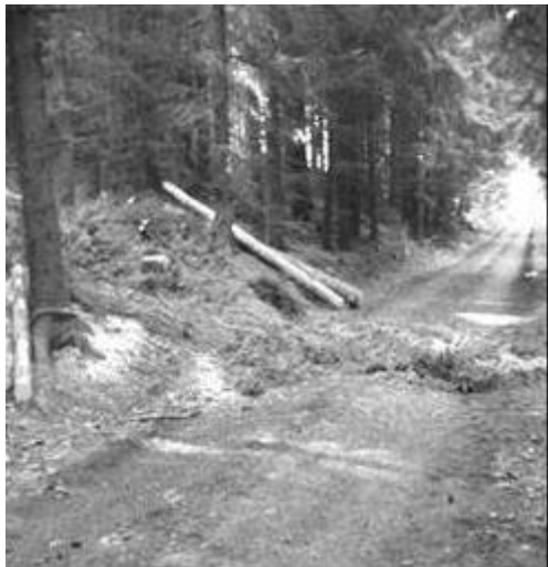
Obr. 6.8.1. Vyvážecí linka v napojení na odvozní cestu s živčným povrchem. Na styčné ploše cesta i linka překryty vrstvou klestu tak, aby povrch nebyl při vytáčení podvozkem vyvážecího traktoru narušen. Výřezy ležící na okraji porostu slouží jako odrazníky, aby nebyl narušen příkop cesty.
