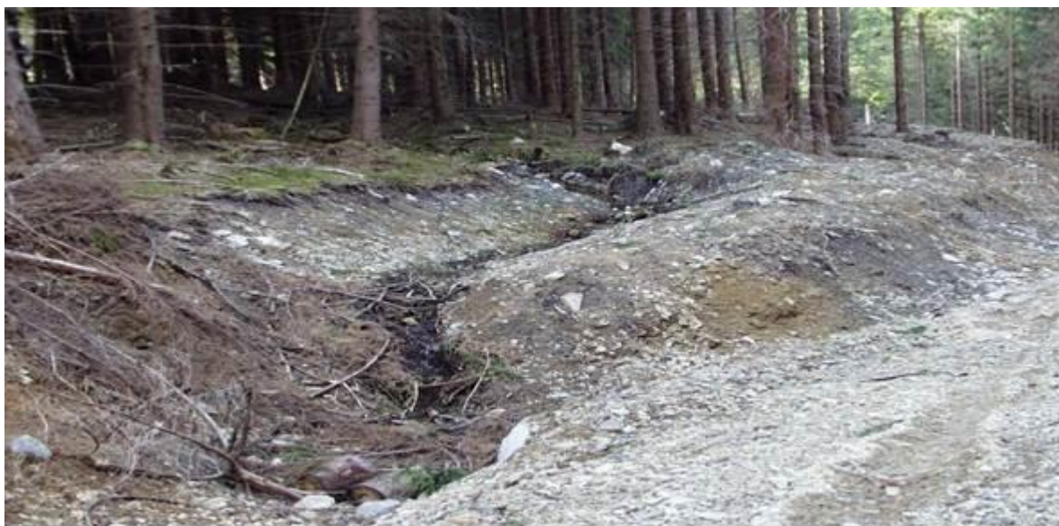
Obr. 6.3. Zemní cesta se zaústěním odvodnění lesního porostu trojúhelníkovou úpravou
