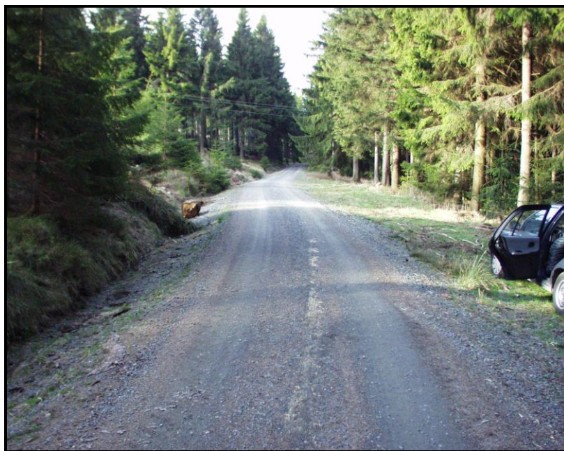
Obr. 6.2. Zemní cesta po výstavbě, zhutněná za optimálních vlhkostních podmínek, trojúhelníkové příkopy budou použitelné pro skládky dříví
